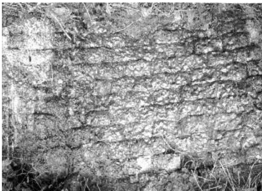
Blauer See, Ratingen: Überrest eines Schachtofens mit Holzfeuerung. Die Oberfläche der Bruchsteine ist bis zur Sinterung erhitzt und hierbei mit einer glänzenden Glasur überzogen worden
