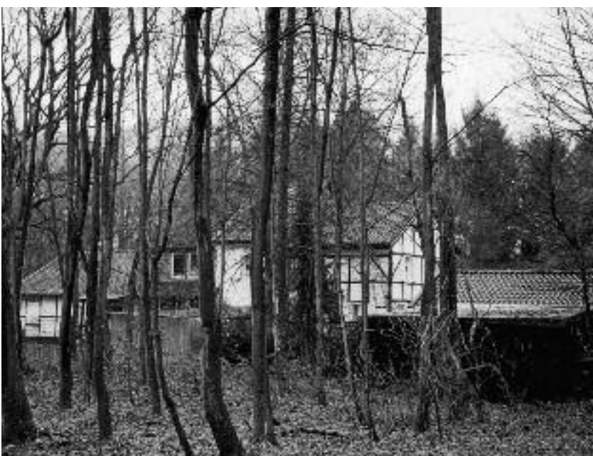
Das „Haus in der Drucht“ im heutigen Zustand. In der Mitte das alte Fachwerkhaus aus der 2. Hälfte des 18. Jahrhunderts. Ganz links ein Fachwerkhaus aus dem 19. Jahrhundert. Zwischen den beiden Häusern ein moderner Verbindungsbau von 1965
