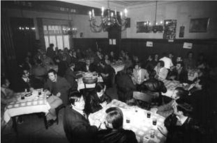
Ein beliebter Treffpunkt für die ersten Griechen in Ratingen war die Gaststätte „Zum Krug“ an der Ecke Bahnstraße/Freiligrathstraße. Sie wurde beim Ausbau des innerstädtischen Verkehrsringes abgerissen
