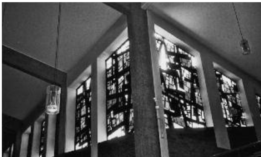
Farbige Betonglasfenster geben dem Hauptschiff und den Seitenschiffen von St. Suitbertus gedämpftes Licht
