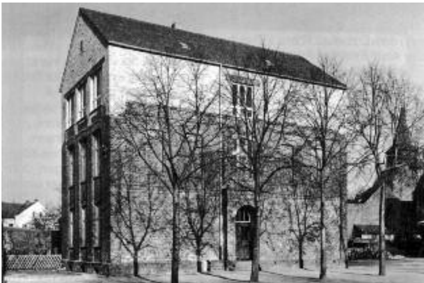
Um die ersten beiden Klassen der neuen Realschule aufnehmen zu können, wird das alte Hofgebäude der ehemaligen Katholischen Schule I an der Minoritenstraße 1955 mit einem zusätzlichen Stockwerk versehen
