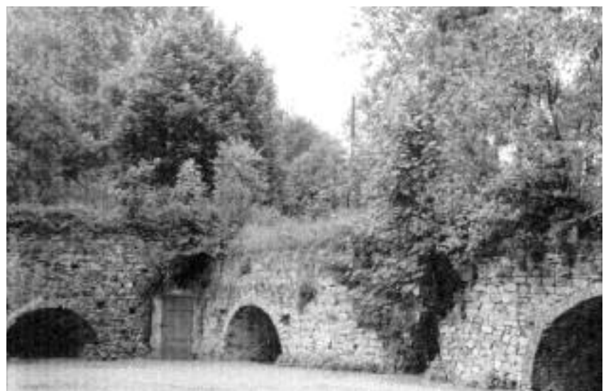
Blauer See, Ratingen: Anlage von drei Trichteröfen. Sichtbar sind die seitlichen Gewölbe, in denen der gebrannte Kalk abgezogen wurde. Die Ofenfüllung mit Kalkstein erfolgt von oben, hier nicht sichtbar
