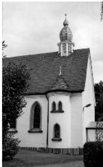
Die kleine neugotische Kirche St. Petrus Canisius wurde 1959 von Kurt Schweflinghaus erweitert
