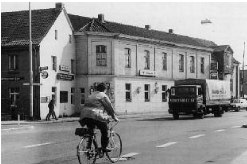
In der Gaststätte „Osterwind“ am früheren Bahnübergang Bahnstraße/ Homberger Straße fand am 11. Februar 1957 die eigentliche Gründungsversammlung der „Ratinger Jonges“ statt
