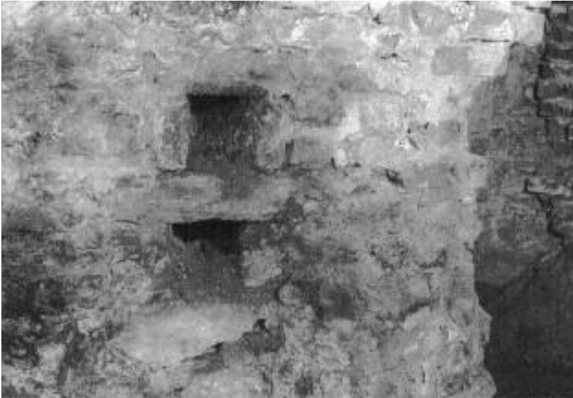
Die Luftzuführung zur vermauerten Brennkammer erfolgte über einen Schacht von 15 x 15 cm. Die untere Öffnung führte zur Brennkammer. Die obere Öffnung ist nur eine Nische zur Aufnahme eines Klotzes, der zum teilweisen Verschließen des Luftschachtes diente
